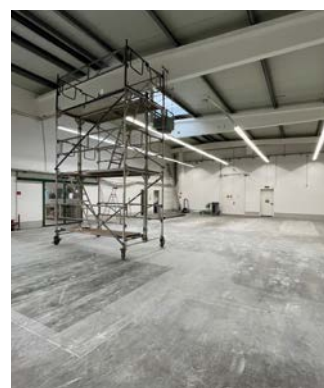
Alles wurde entkernt und wird nun komplett neu ausgebaut.
